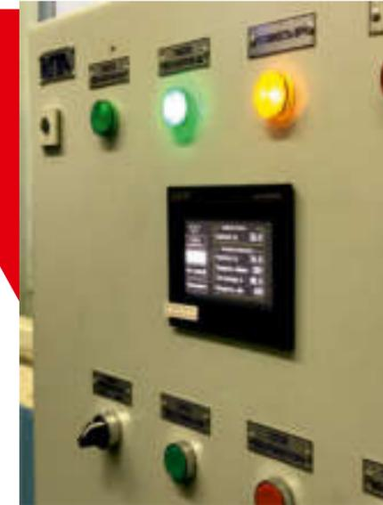
Система управления предназначена для обеспечения питанием и управлением дымососами и дутьевыми вентиляторами.
