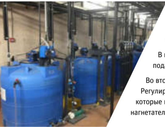
Принцип действия системы основан на возвратно-поступательном движении плунжера внутри корпуса рабочей камеры. В результате в ней создаются попеременно стадии разрежения и нагнетания.
